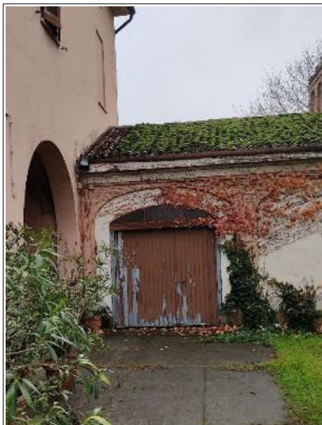
Figura 11 – Vista esterna edifici accessori
