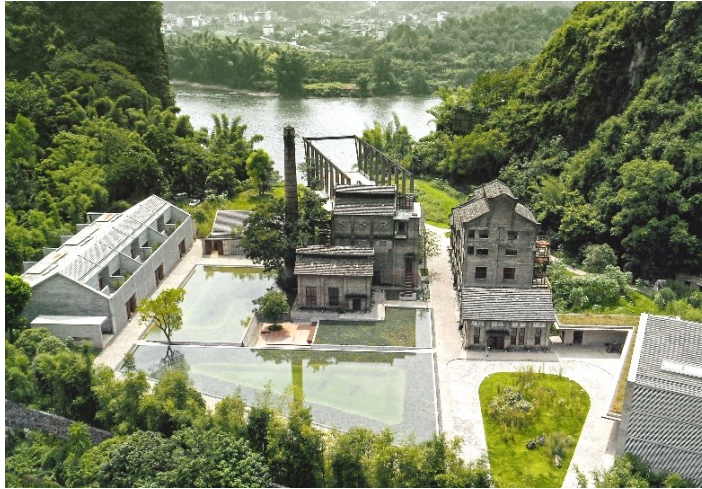
Esempio di innesto urbano: il progetto del nuovo mutua i caratteri tipologici e morfologici dall'esistente. Il diverso trattamento materico consente la lettura delle differenti fasi dell'intervento (VECTOR ARCHITECTS, ALILA YANGSHUO HOTEL, Guilin (Cina), 2018)
