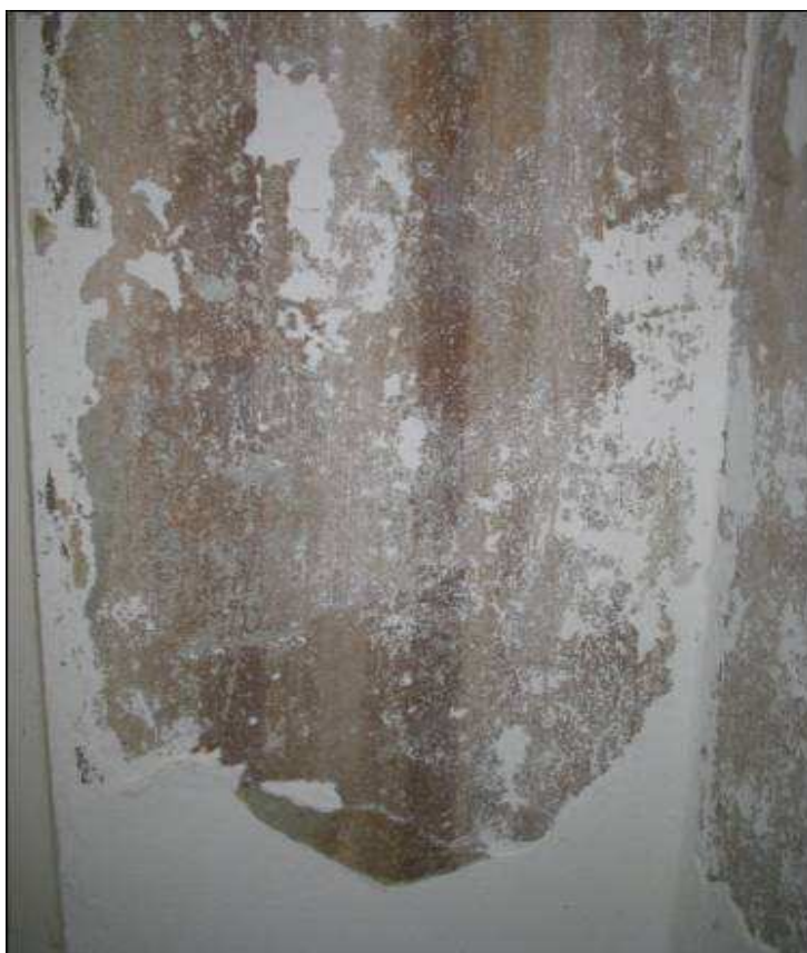
Foto n. 10 – Vista scrostamento intonaco in atto
