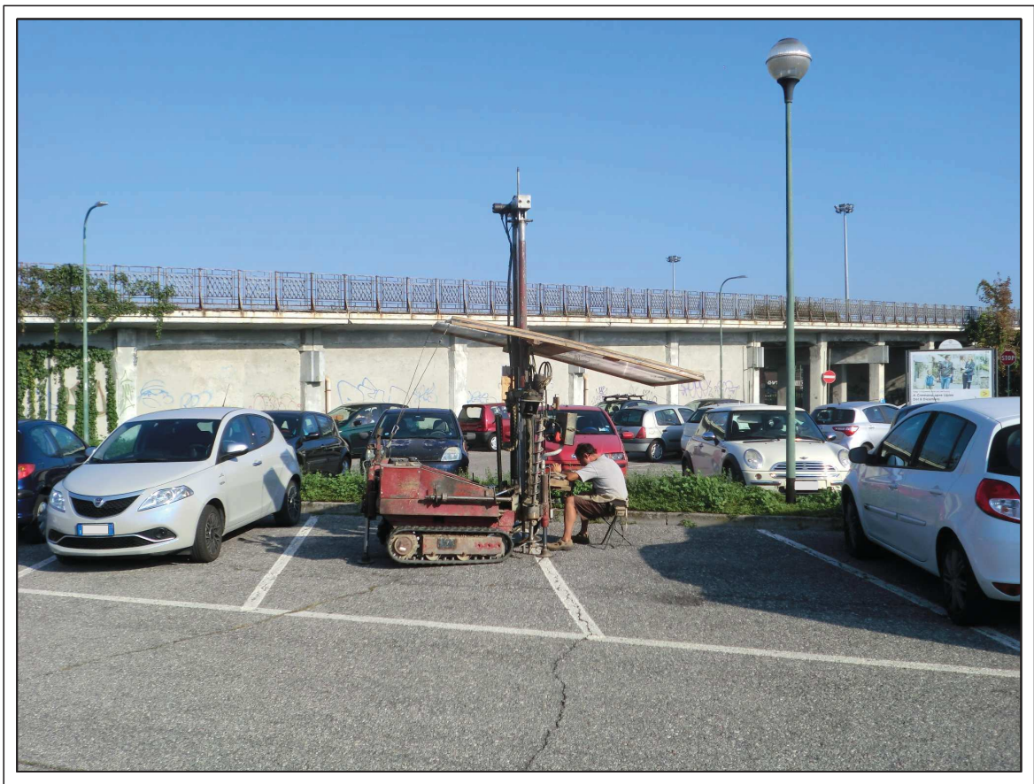
Fig. 1 - Esecuzione della prova penetrometrica dinamica SCPT1 (05/09/2018)
